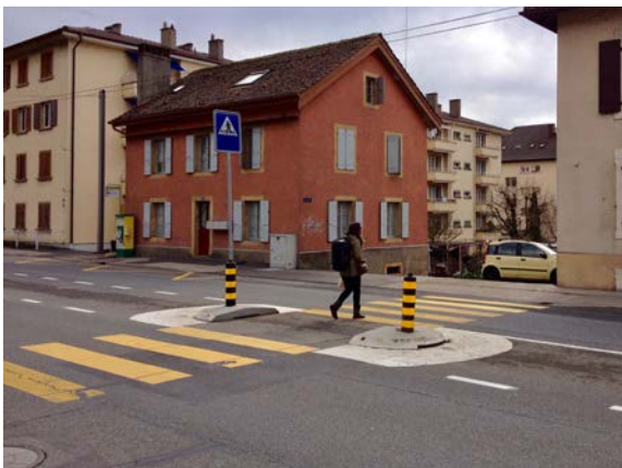
Illustration 19. Les passages piétons avec îlot facilitent et sécurisent la traversée, qui s'effectue en deux temps.
